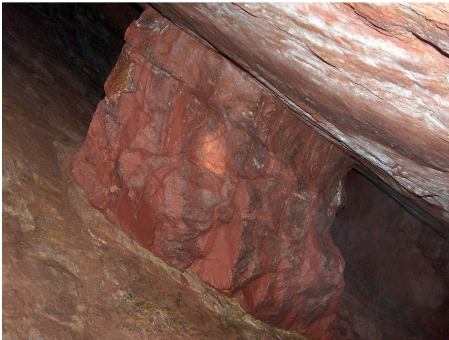
Abb. 10. Stützpfeiler in der Grube Volkmar. Deutlich ist das ziegelrote, mit etwa 50° einfallende Eisenerzlager erkennbar.
