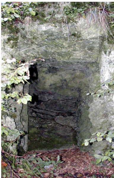
Abb. 11. In den Fels gehauenes Sprengstofflager (siehe Abb.2).
