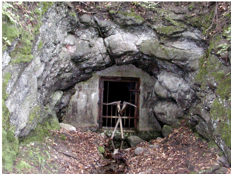
Abb. 9. Mundloch des Entwässerungstollens der ehemaligen Eisenerzgrube Mittelberg in Schalstein gehauen, direkt neben dem Klostergrund gelegen (die Höhe der Bergmannshacken entspricht 90 cm).
